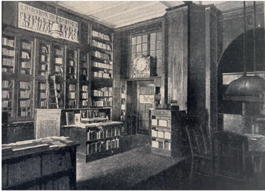
Verkaufsraum im Erdgeschoss. Linke Hälfte mit Personen-Aufzug.
