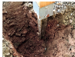
Für die Fundamente wird ein Loch ausgehoben.
