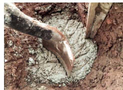
Mit schnell härtendem Fertigbeton verfüllt.
