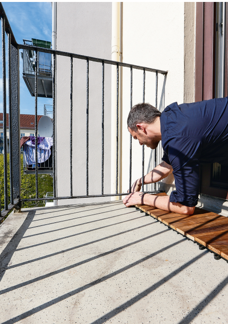
Nachher: Klickfliesen verdecken den Beton.
